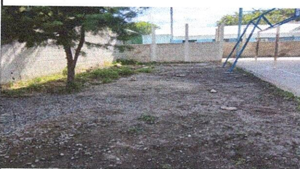
Foto 3: MANTENIMIENTO DE LOSA DE PATIO
